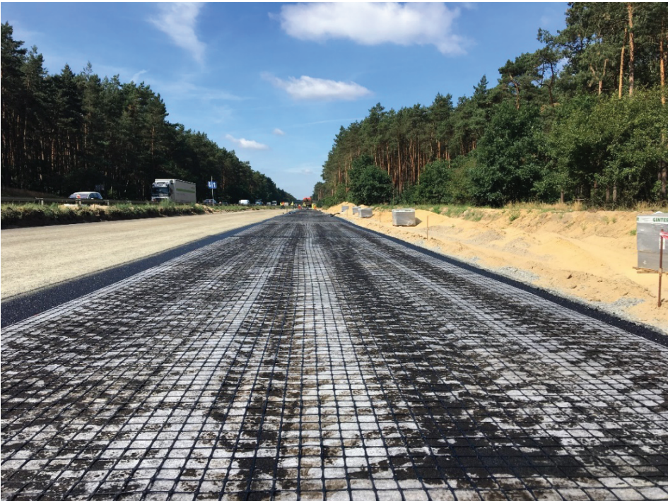
Fot. 2. Widok prawidłowo zainstalowanego kompozytu (fot. Autora)
