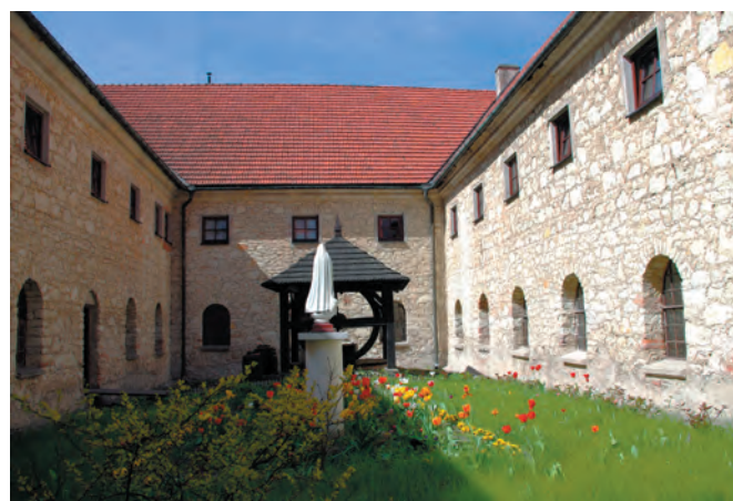
Fot. 3. Klasztor Braci Mniejszych (Franciszkanów Reformatorów) z lat 1638-68 wykonany w przewadze z miejscowego budulca (opok kredowych)
