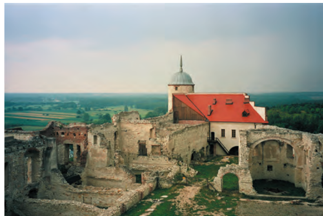
Fot. 1. Widok XVI w. zamku rodziny Firlejów w Janowcu, wykonanego z opok kredowych
