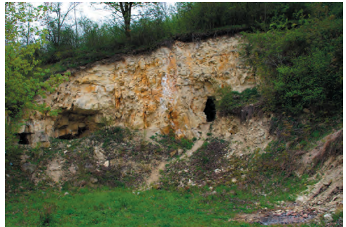
Fot. 10. Inne, dawne miejsce komorowej eksploatacji opok w Bochothnicy k. starego młyna wodnego Fot. 10. Another abandoned opoka quarry in Bochothnica near the old watermill.
