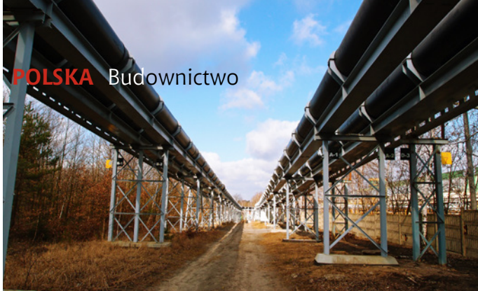
Przewody PE-HD DN 900 do transportu odpadów poliflotacyjnych na podporach
