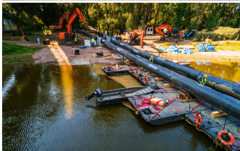
Budowa rurociągu na moście pontonowym w Warszawie po kolejnej awarii systemu przesyłającego ścieki do oczyszczalni „Czajka” w 2020 r.
