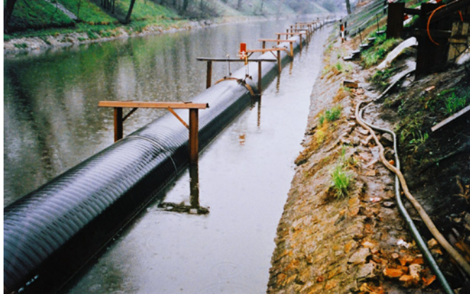
Pływający bypass we Wrocławiu – wielokrotnie rozmontowywany i ponownie instalowany
