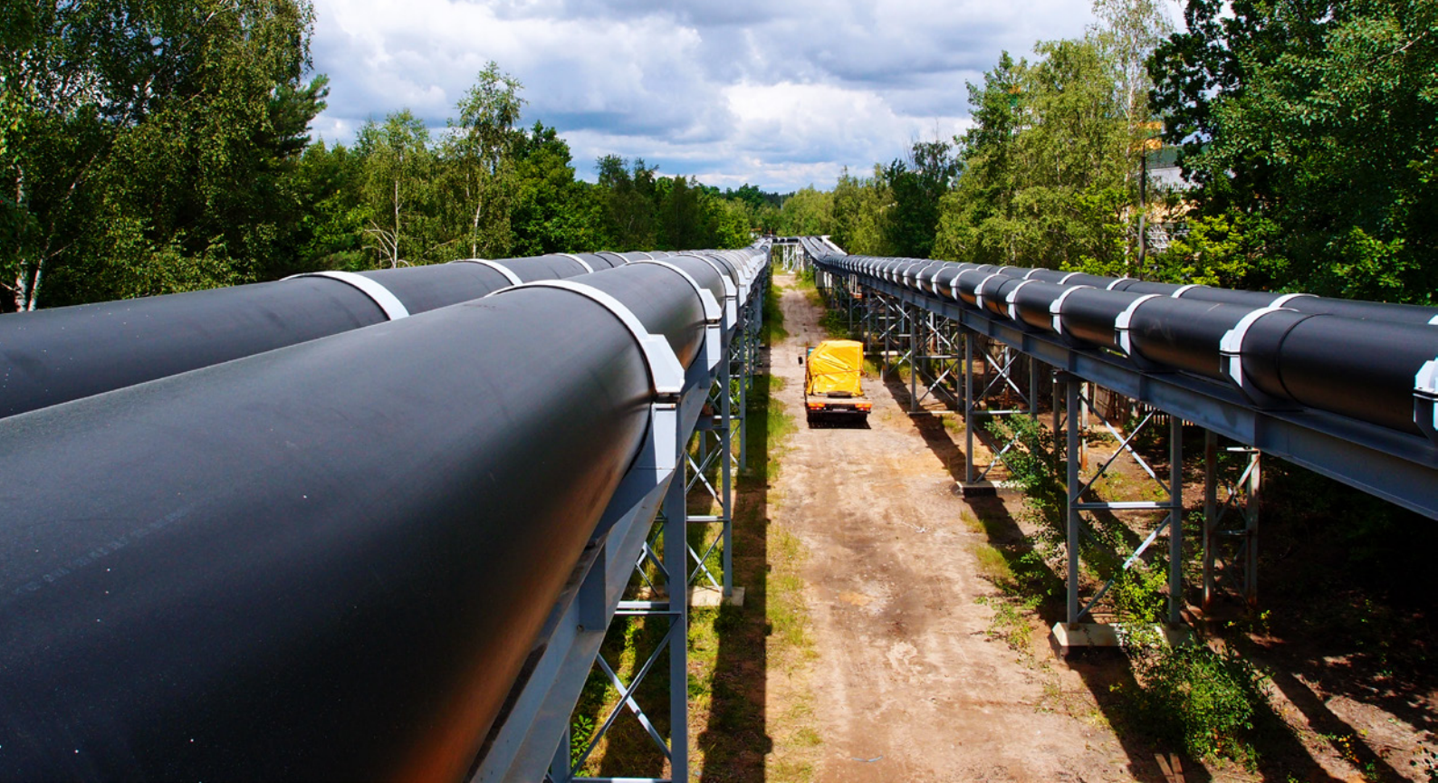
KGHM Polska Miedź SA – wykorzystanie rurociągów PE-HD do transportu odpadów poflotacyjnych
