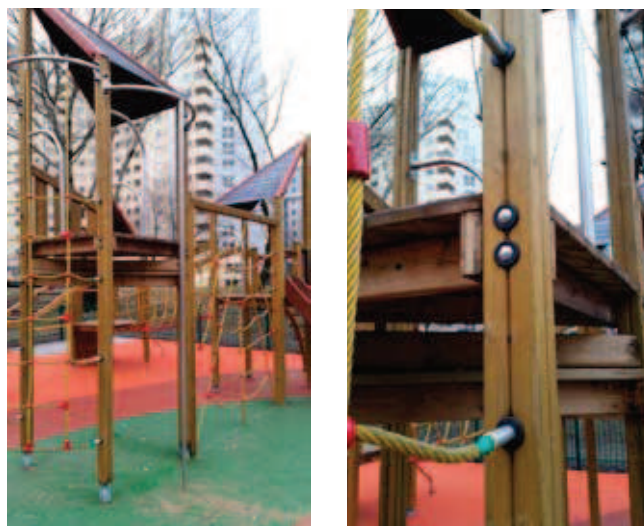
Rys. 1. Najwyższa wieżyczka na przykładowym placu zabaw: a) widok ogólny; b) widok rozpatrywanego połączenia
