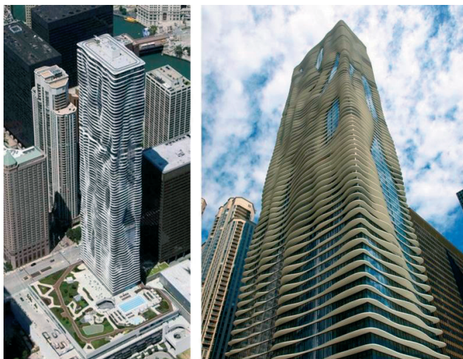
Rys. 6. Widok budynku Aqua Tower [10]
