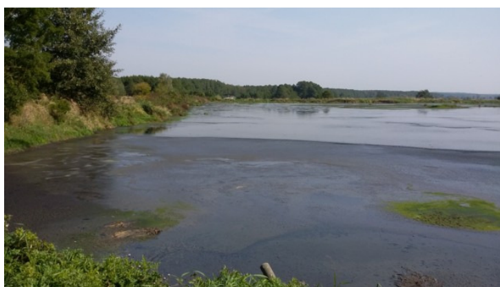
Rys. 2. Widok na kolektor tłoczący osady na lagunę nr 2 (wrzesień 2014 r.) Fig. 2. View on the sludge pumping collector to lagoon No 2 (September 2014)
