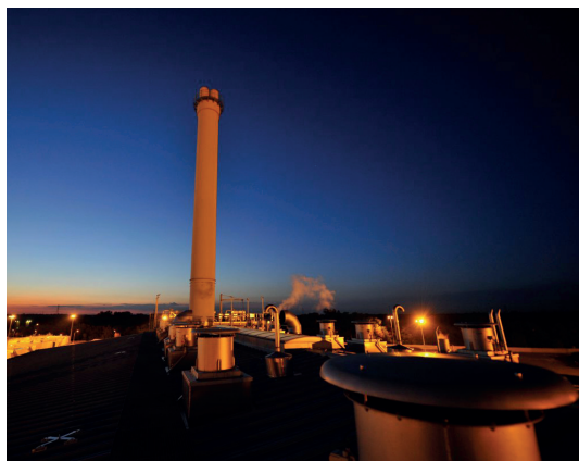
Instalacja w oczyszczalni ścieków Czajka
