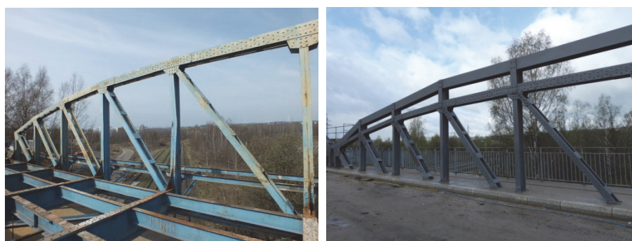
Rys. 6. Widoki dźwigara kratowego przed (a) i po wzmocnieniu (b)
