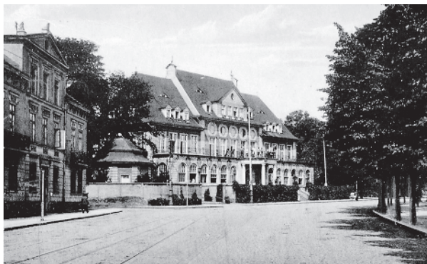
Ryc. 16. Główny budynek Strzelnicy. Stan po rozbudowie przeprowadzonej w 1912 roku. Widok od strony dzisiejszej ulicy 3 Maja. Z lewej strony widoczny jest wjazd na obecną ulicę Kurkową, a po prawej lipowa aleja, będąca ulubionym miejscem spacerów gdańszczan. Pocztówka z ok. 1915 roku. Ze zb. Krzysztofa Szczecińskiego
