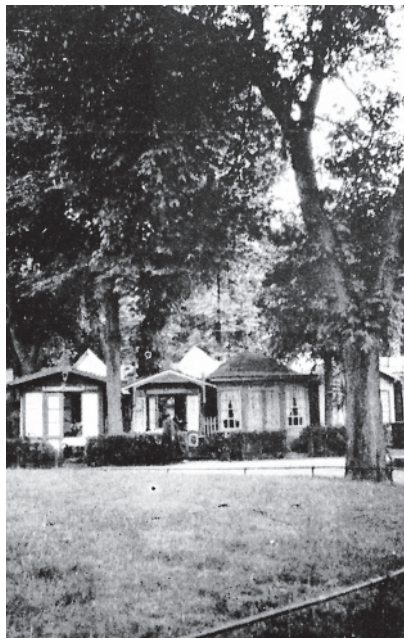
Ryc. 14. Letnie altanki budowane na terenie ogrodu od ok. połowy XIX wieku. Fotografia z początku lat trzydziestych. Źródło: A. Bertling, Schützengarten und Schützenhaus in Danzig im Wandel der Zeit , Danzig 1932, il. 8
