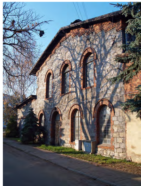
Ryc. 12. Budynki gazowni z około 1870 r. – Strzelin, m. i gm. Strzelin (fot. B. Jawecki)
