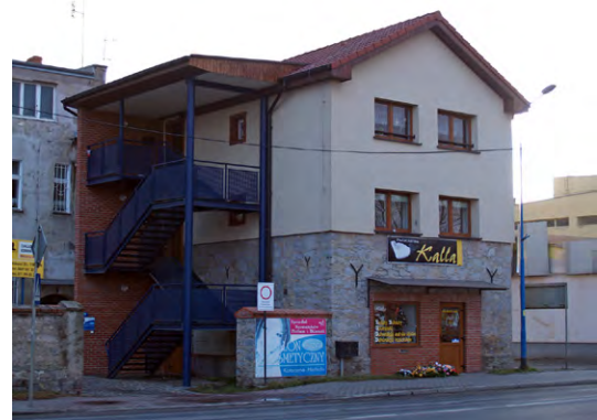
Ryc. 14. Budynek centrali nasiennej zaadaptowany na lokale mieszkalne i usługowe – Strzelin, m. i gm. Strzelin (fot. B. Jawecki)
