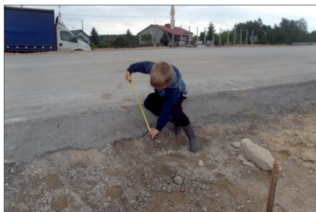
Ryc. 7. Budowa drogi. Fot. S. Wołkowicz
