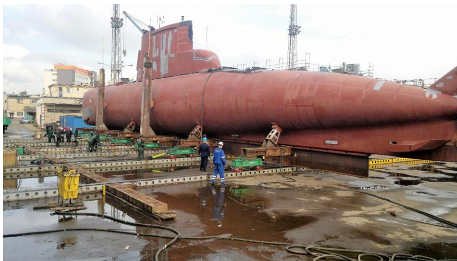
Rys. 13. Przemieszczanie hydrauliczne ładunków ponadgabarytowych Źródło: Opracowanie własne.
