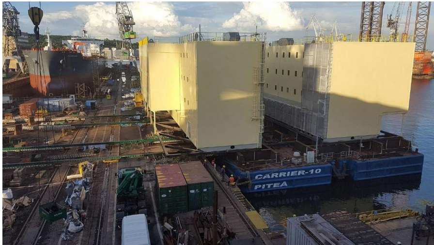
Rys. 12. Przesuwanie ładunków ponadgabarytowych na ponton w porcie Gdynia
