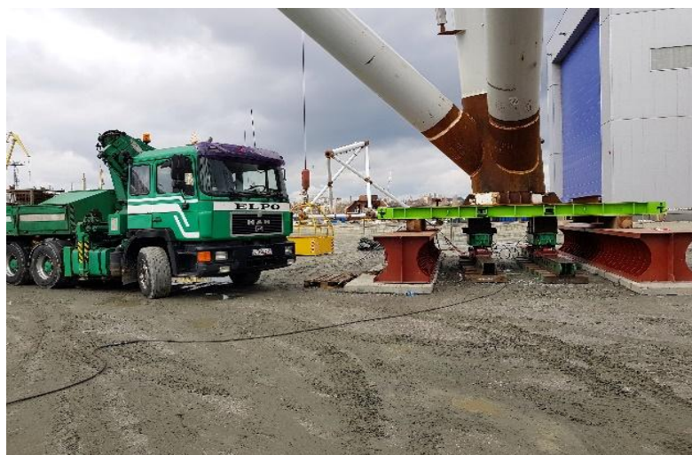
Rys. 8. Ważenie fundamentów JACKET
