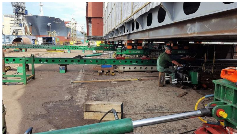
Rys. 10. Przesuwanie ładunków ponadnormatywnych w portach
