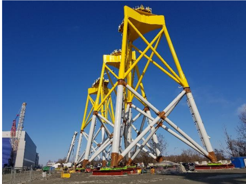
Rys. 9. Wyznaczanie środka ciężkości fundamentów JACKET
