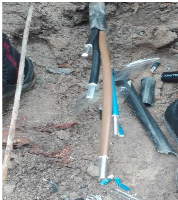
Rys. 13. Proces przygotowawczy do wstawkowej. Żyły przycięte na mijanego [fot. Opracowanie własne autorów artykułu]
