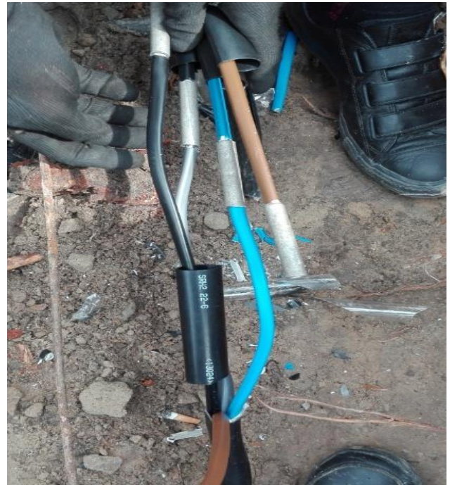
Rys. 17. Połączenie dwóch końców, tego samego przewodu [fot. Opracowanie własne autorów artykułu]
