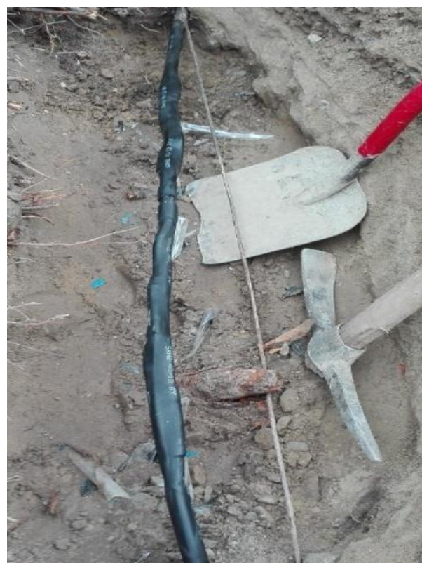
Rys. 28. Prawidłowo wykonana naprawa kabla elektroenergetycznego znajdującego się w ziemi [fot. Opracowanie własne autorów artykułu]
