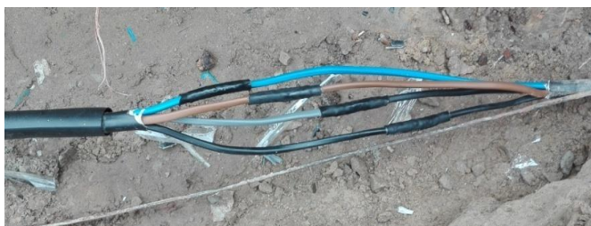
Rys. 26. Założona pierwsza mufa kablowa [fot. Opracowanie własne autorów artykułu]
