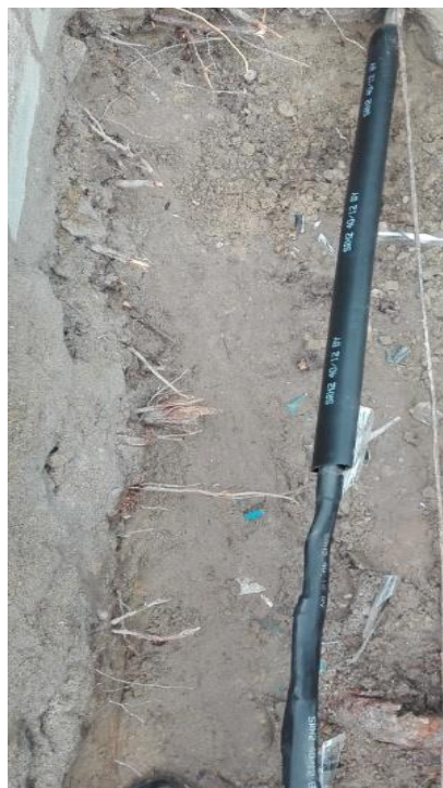
Rys. 27. Zakładanie wstawki kablowej [fot. Opracowanie własne autorów artykułu]
