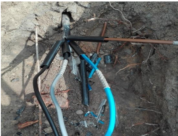
Rys. 19. Zaprasowane tuleje gotowe do zaizolowania [fot. Opracowanie własne autorów artykułu]
