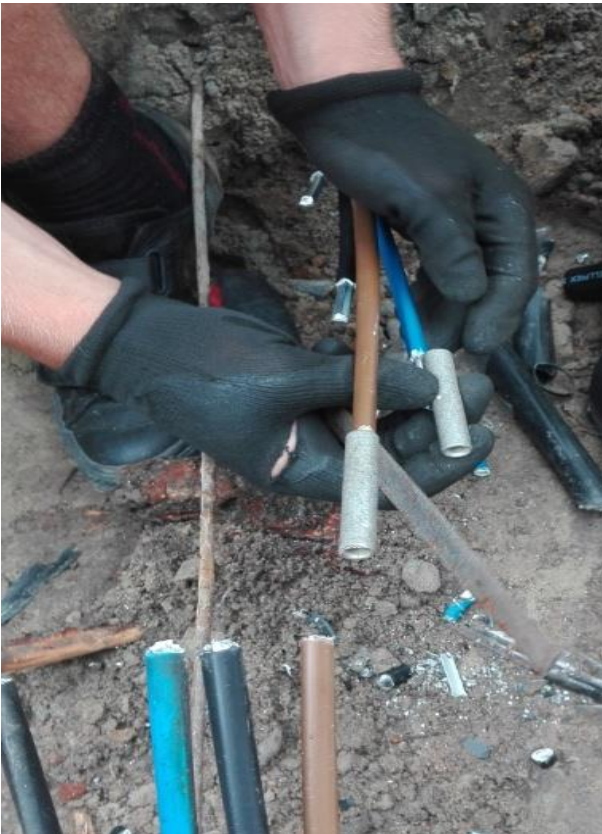
Rys. 15. Montaż osprzętu kablowego w postaci tulejek [fot. Opracowanie własne autorów artykułu]
