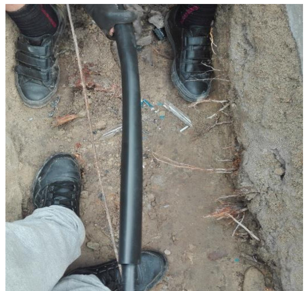
Rys. 24. Zakładanie mufy termokurczliwej [fot. Opracowanie własne autorów artykułu]
