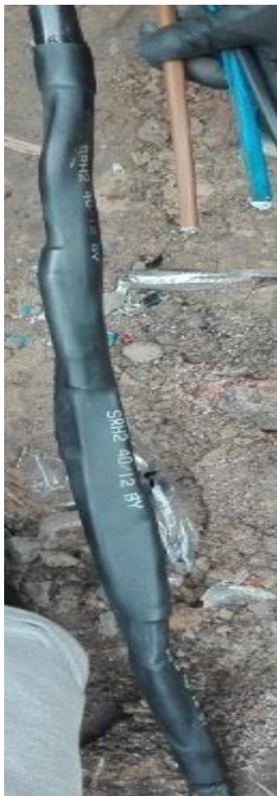
Rys. 25. Zgrzewanie mufy kablowej [fot. Opracowanie własne autorów artykułu]
