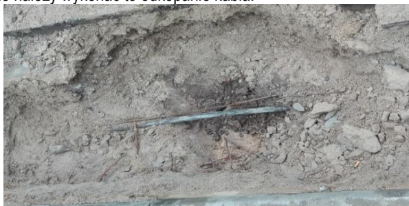
Rys. 11. Odkopywanie kabla [Opracowanie własne autorów artykułu]
