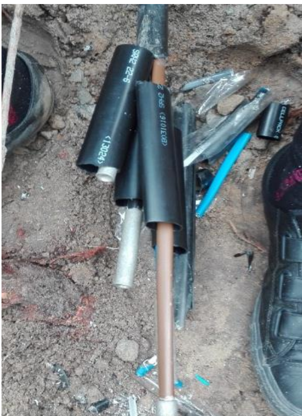
Rys. 16. Proces odnowy izolacji wewnętrznej poszczególnych żył [fot. Opracowanie własne autorów artykułu]
