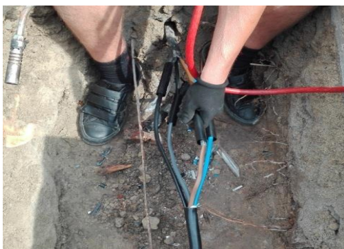
Rys. 21. Prawidłowo przygotowany kabel do procesu zgrzewania [fot. Opracowanie własne autorów artykułu]
