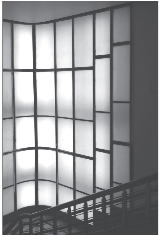
22. Czesław Jabłoński, Józef Korszyński, klatka schodowa w dawnym Gmachu Administracyjnym Elektrowni Miejskiej w Warszawie (obecnie siedziba RWE Polska S.A.), ul. Wybrzeże Kościuszkowskie 41, 1937–1939.
