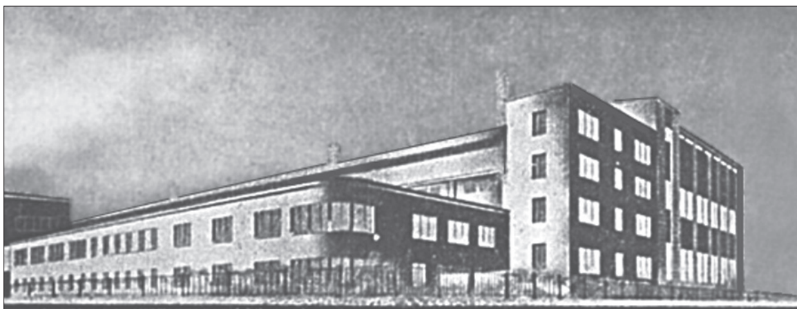
20. Jan Tokarzewski, projekt przebudowy Rozdzielni 5-15 kV i komory wodnej Elektrowni Miejskiej w Warszawie, 1938 r.
