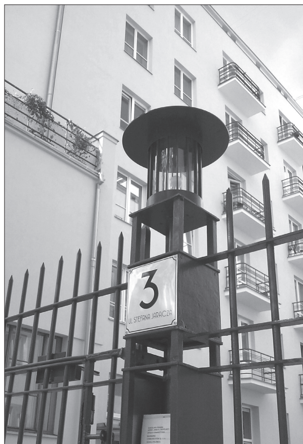
5. Piotr Kwiek, kamienica Spółdzielni Mieszkaniowej Urzędników Banku Polskiego „Nowe Domostwo” w Warszawie, ul. Jaracza 3, 1929–1931. Fot. autor, 2014 5. Piotr Kwiek, “Nowe Domostwo”, the house of the Polish Bank Cooperative at 3 Jaracza St in Warsaw, 1929–1931. Photo by F. Burno, 2014
