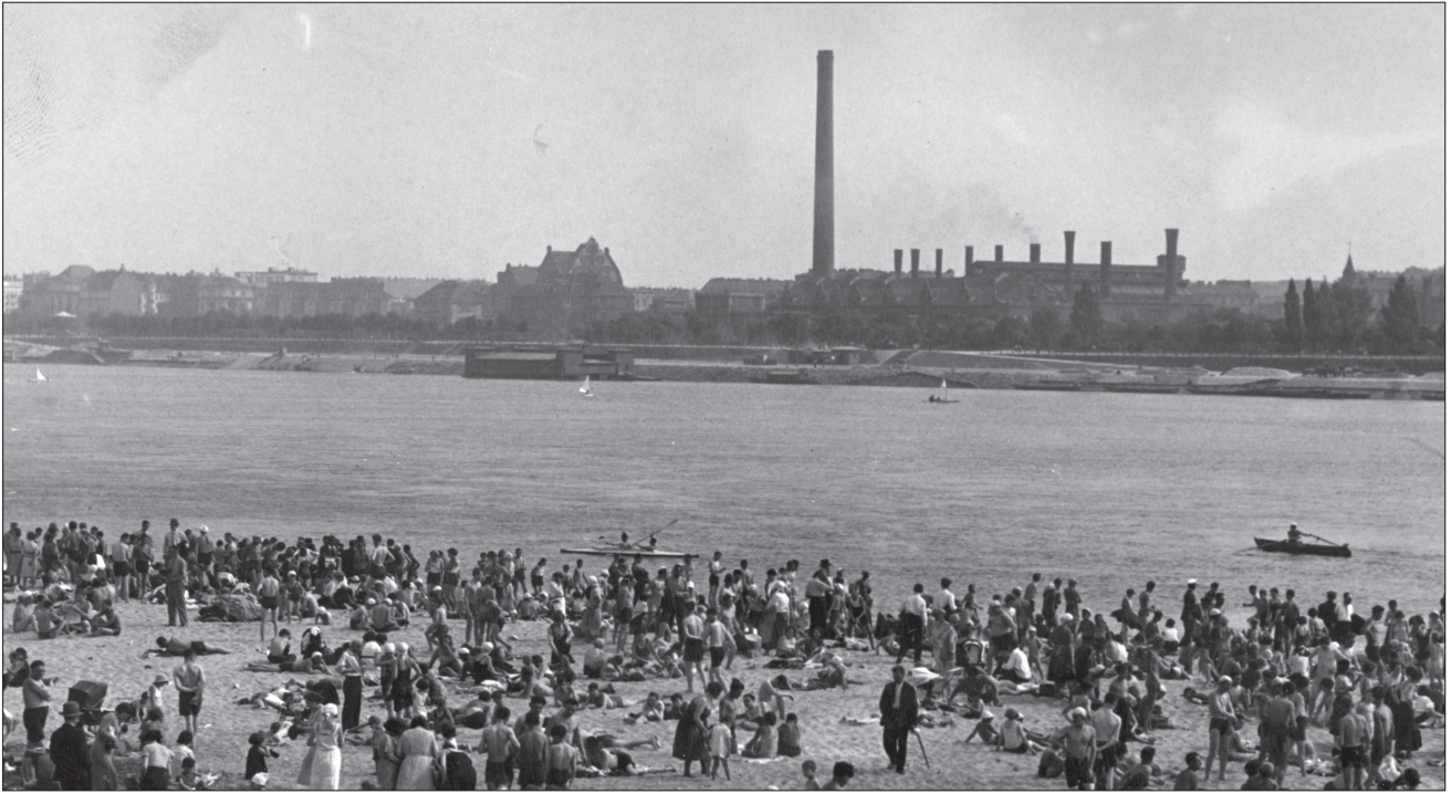
13. Dzika plaża nad Wisłą na praskim brzegu Warszawy, widok na Wybrzeże Kościuszkowskie, lipiec 1931 r. Źródło: NAC 13. An unguarded beach on the Praga bank of the Vistula in Warsaw, a view of Wybrzeże Kościuszkowskie, July 1931. From: NAC
