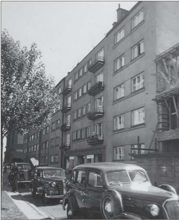
23. Ulica Czerwonego Krzyża (obecnie Stefana Jaracza), widok od ul. Dobrej w stronę Wybrzeża Kościuszkowskiego, fot. z maja 1939 r. Źródło: AP Warszawa, sygn. 3402 23. Czerwonego Krzyża Street (now Jaracza Street), a view from Dobra Street towards Wybrzeże Kościuszkowskie, a photograph from May 1939 r. From: AP Warszawa, signature 3402
