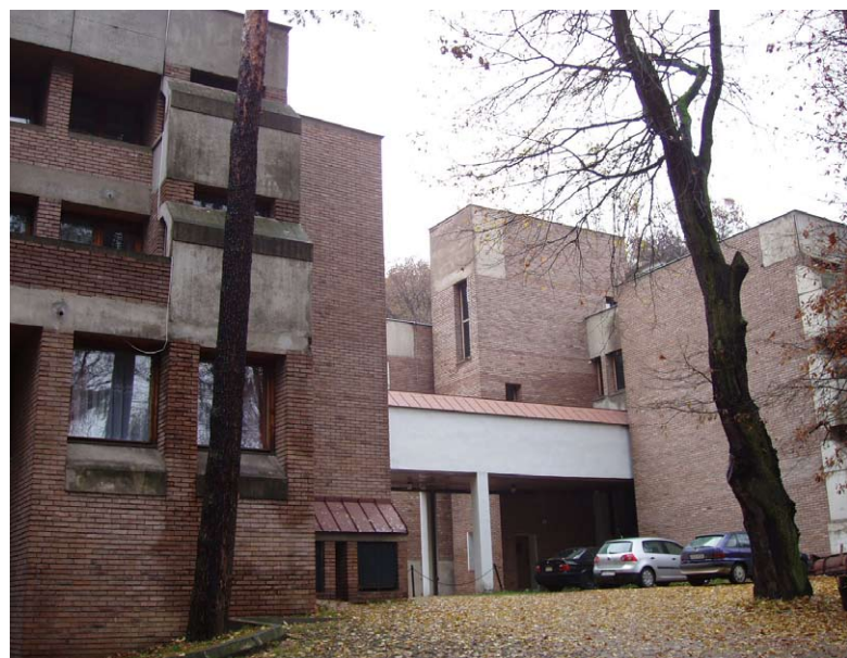
Ryc. 10. Collegium Polonijne UJ – widok w kierunku kładki, wertykalna bryła mieszcząca jedną z klatek schodowych w tle. Fot. autor
