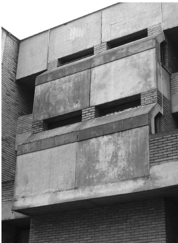
Ryc. 17. Kolegium Polonijne UJ – żelbetowe wykusze. Fot autor
