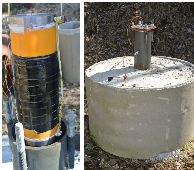
Rys. 8. Montaż modelowego odcinka perfogeneratora w betonowym obiekcie z uszczelnieniem zamknięcia odwiertu
