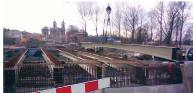
Fot. 3. Przykłady uciąglenia dźwigarów za pomocą sztywnej monolitycznej poprzecznicy: a) uciąglenie belek typu T, droga S12 Lublin (2021); b) budowa mostu zintegrowanego, dźwigary typu VFT, Piaski pod Lublinem (2009)
