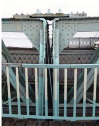
Fot. 4. Most „Blaues Wunder” w Dreźnie nad Łabą: a) widok od strony napływu; b) i c) konstrukcja przegubu w osi mostu
