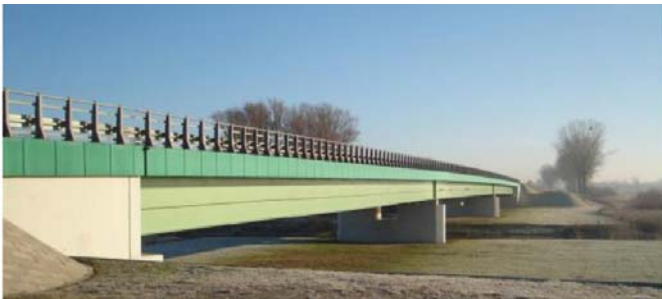
Fot. 2. Mosty zespolone z ustrojami ciągłymi o stałej wysokości konstrukcyjnej belki stalowej: a) most w Dorohucz (2006); b) most w Osuch (2008)
