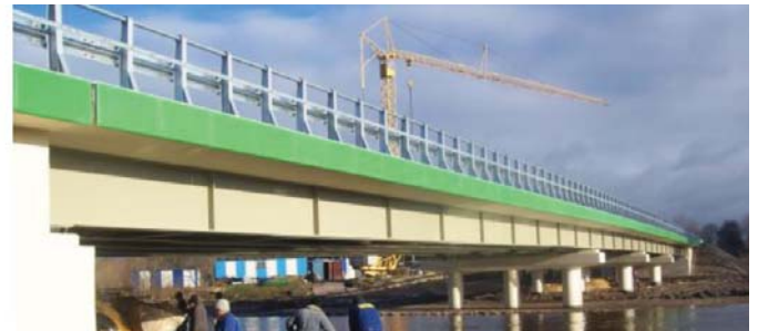
Fot. 2. Mosty zespolone z ustrojami ciągłymi o stałej wysokości konstrukcyjnej belki stalowej: a) most w Dorohucz (2006); b) most w Osuch (2008)
