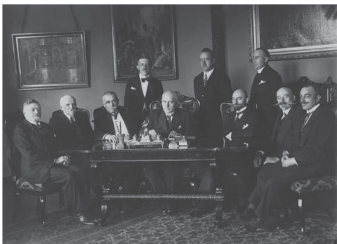
Fot. 6. Posiedzenie Komitetu Odbudowy I-jej połowy mostu ks. J. Poniatowskiego w Warszawie (inż. Stróżecki siedzi trzeci od lewej strony, a tuż za nim stoi inż. Plebiński), Most i wiadukt imienia Ks. Józefa Poniatowskiego przez rzekę Wisłę w Warszawie, Warszawa 1927 (Narodowe Archiwum Cyfrowe, sygn. 1-G-3492)
