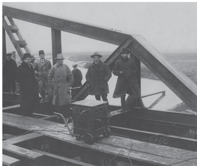
Fot. 9. Profesor Stefan Bryła (drugi od lewej strony) podczas pełnienia nadzoru nad spawaniem dźwigarów mostu przez Słudwię pod Łowiczem (Narodowe Archiwum Cyfrowe, sygn. 1-G-3400-1)
