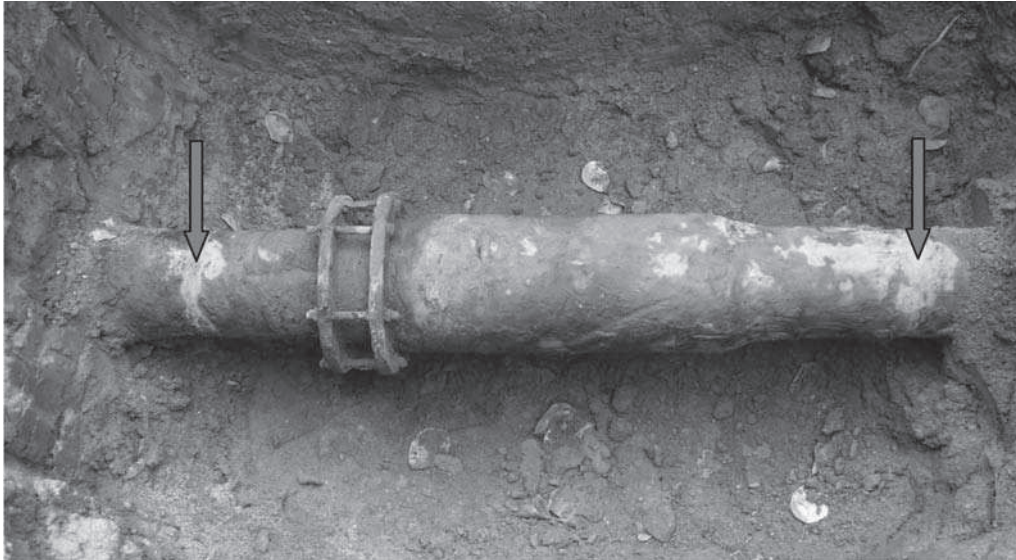
Rys. 6. Kompensator dławikowy zamontowany na sieci gazowej. Źródło: Opracowanie własne Fig. 6. Gland compensator mounted on the gas pipeline. Source: Own elaboration
