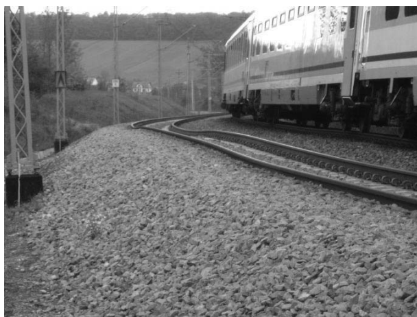
Rys. 2b. Maj 2010 roku - przejazd pociągu po zdeformowanym torze (mat. arch. PLK)
