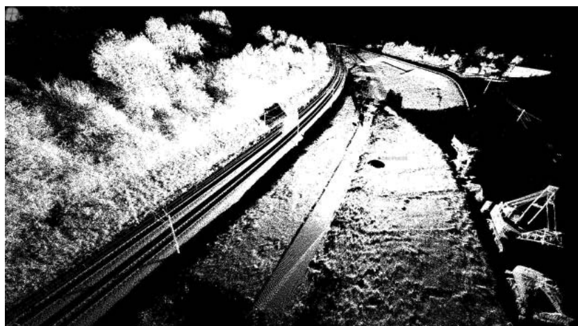
Rys. 12. Ogólny skan osuwiska w Sadowiu wraz z linią kolejową
