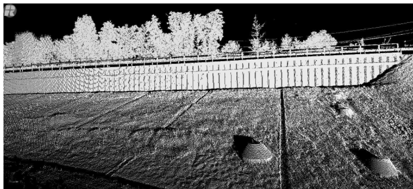
Rys. 13. Skan części osuwiska w Sadowiu po zabezpieczeniu larsenami
