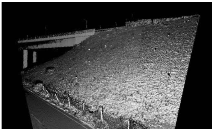
Rys. 9. Nasyp drogowy - obraz wykonany naziemnym skanerem laserowym w Wielkiej Brytanii w celu monitorowania deformacji [13]
