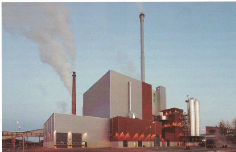
Rys. 5. Spalarnia odpadów przemysłowych Oulu, Finlandia
