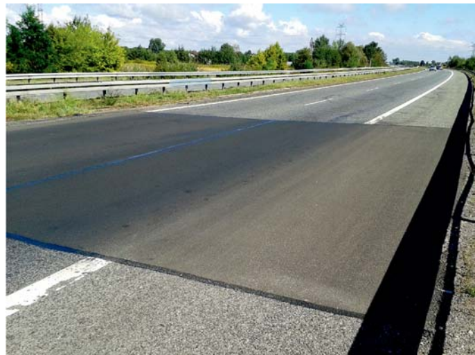
Fot. 3. Droga S8. Łata w miejscu naprawy pęknięcia poprzecznego nawierzchni jezdni
