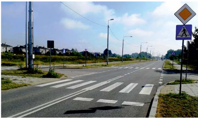
Fot. 4. Oznakowanie poziome przejścia dla pieszych na skrzyżowaniu ulic Skalnicowej i Południowej
