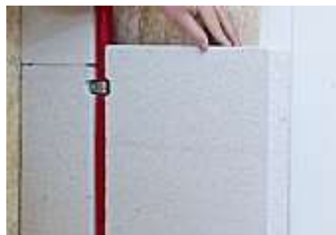
Fot 3. Zabudowa rury grzewczej [11].
