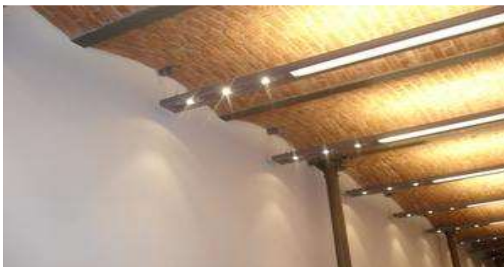
Fot 5. Ściany docieplone od wewnątrz płytami mineralnymi Multipor [12].
