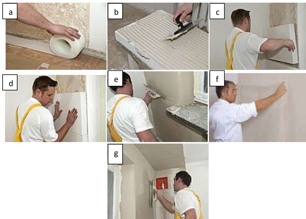
Fot. 1. a–g. Kolejne etapy montażu płyt Multipor [11].
