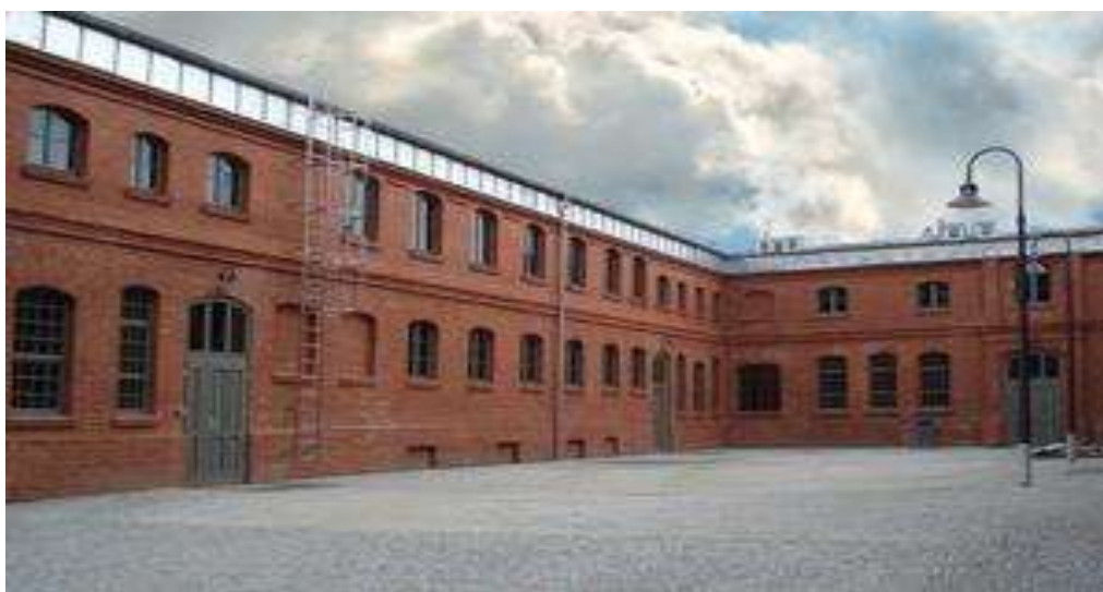
Fot. 4. Budynek należący do kompleksu Wojewódzkiego Sądu Administracyjnego w Poznaniu [12].
