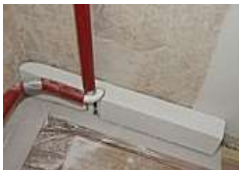
Fot. 2. Izolacja rur grzewczych [11].
