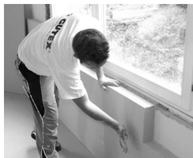
Rys.6. Zastosowanie wełny drzewnej od wewnątrz. [10].
