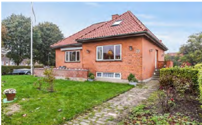
Rys. 6. Jednorodzinny dom w Sønderby podłączony do sieci Høje-Taastrup Fjernvarme a.m.b.a.
