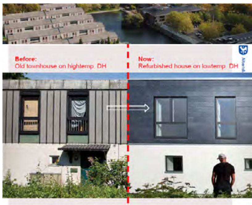
Rys. 4. Albertslund - budynki przed i po modernizacji Źródło: Gmina Albertslund
