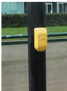
Fot. 9. Słupek tablicy zmiennej treści na przystanku tramwajowym z przyciskiem dla osób słabowidzących
