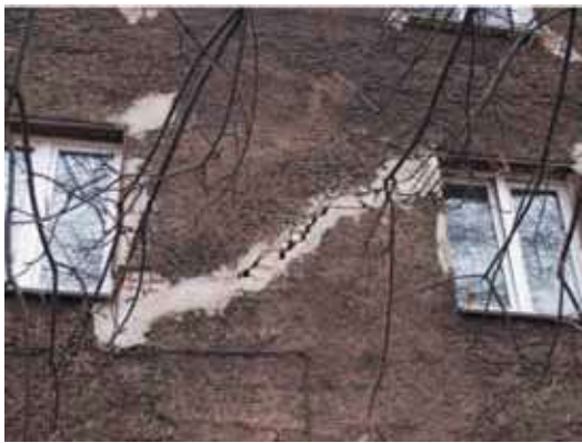
Rys. 6. Ścięcie ścianki międzyokiennej w budynku przy ul. Pocztovej w Bytomiu-Karbiu, fot. L. Słowik, ITB, 2013
