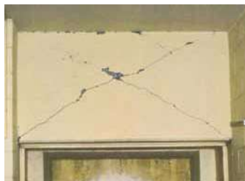
Rys. 3. Uszkodzenie żelbetowego nadproża wysokiego w postaci tzw. krzyża św. Andrzeja Fig. 3. Damage to the brick wall and pillar in the form of so-called the cross of St. Andrew
