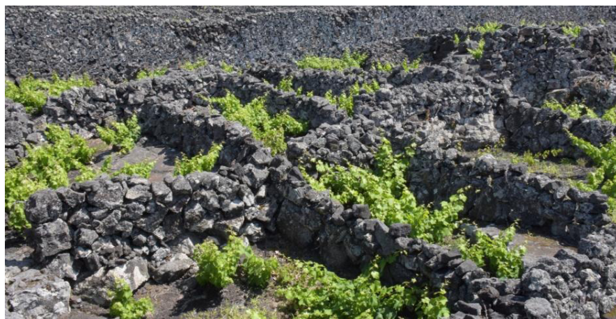
Fot. 2. W krajobrazie dominują kamienne murki pieczołowicie ułożone z bazaltowych kamieni, bez zaprawy. Fotografia wykonana w czerwiec 2019 r. (fot.: J. Makowski)
