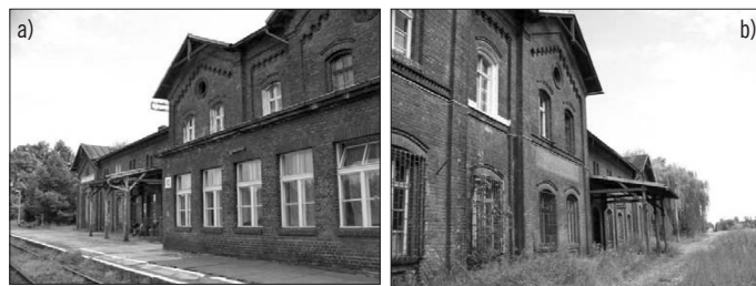
Fot. 2. Dworzec w Nowym Świątowie miał kiedyś charakter dwustronny z peronem obsługującym główną linię Nysa – Kędzierzyn-Koźle (a) i położonym po drugiej stronie budynku stacyjnego, od dłuższego czasu nieczynnym peronem dla tras w kierunku Głuchołaz i Sławniowic (b). W końcowym okresie kursowania pociągów pasażerskich w stronę Głuchołaz korzystały one z peronu przy głównej linii
