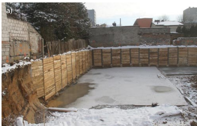
Rys. 2. Budynek mieszkalny wielorodzinny z częścią usługową: a) widok zabezpieczenia wykopu według rozwiązania projektowego ścianek „berlińskich”
