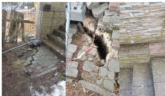
d) widok skutków błędów projektowych i wykonawczych; występuje przemieszczanie się gruntu pod budynkiem przyległym do realizowanej budowy, ewidentny, negatywny wpływ realizowanej budowy na zabudowę sąsiednią, powstałe uszkodzenia wymagają będą skutecznej naprawy
