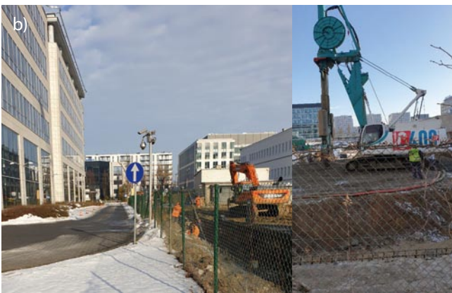
b) widok monitorowanego budynku w strefie oddziaływania geotechnicznego i widok realizacji obiektu oddziaływającego geotechnicznie na zabudowę sąsiednią
