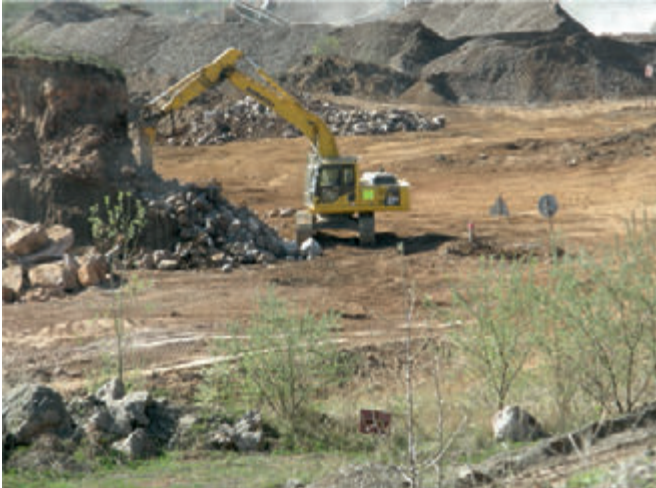
Fot. 7. Młot hydrauliczny w trakcie urabiania dolomitu
