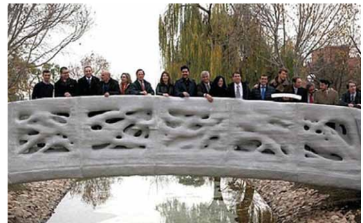
Rys. 9. Wydrukowany w 3D most dla pieszych
