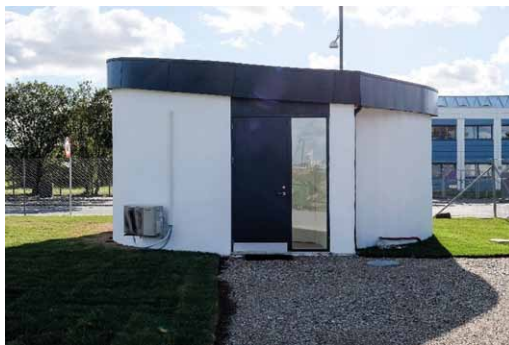
Rys. 6. Budynek wydrukowany w 3D przez firmę COBOD. © COBOD [41]
