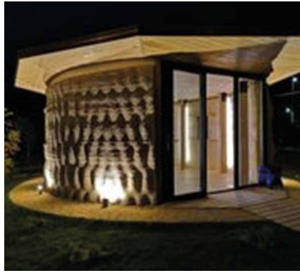
Rys. 5. Zbudowany z ziemi dom Gaia. © WASP
