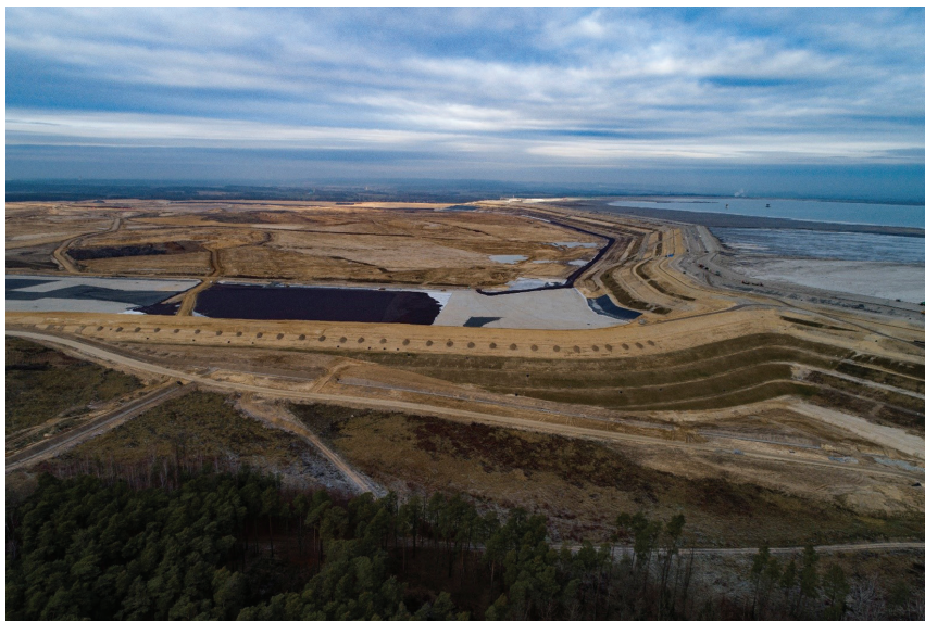
Rys. 1. Widok na teren budowy Kwatery Południowej OUOW Żelazny Most
