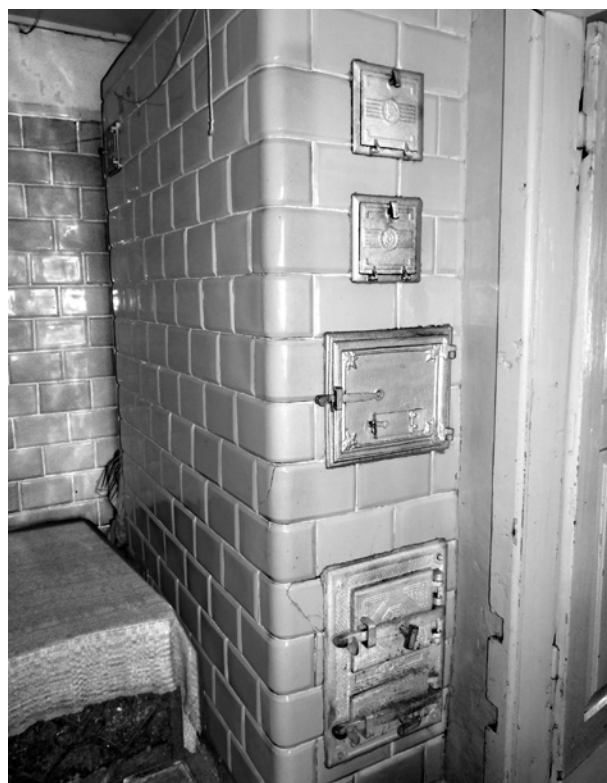
Ryc. 10. Piec ogrzewczy z komorą duchówkową (stojący za piecem kuchennie-wielofunkcyjnym) w pierwszym ze zinventaryzowanych domów w Nowej Woli, będący częścią rozbudowanego systemu (fot. M. Rogozińska, październik 2014 – ujęcie 6 na ryc. 14)
