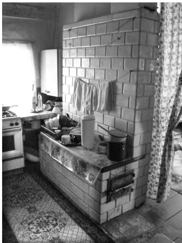
Ryc. 8. Piece kaflowe w dwóch domach we wsi Leonowicze w gm. Michałowo (każdy z pieców jest częścią bardziej rozbudowanego systemu w danym domu; fot. J. Szewczyk, lipiec 2010)
