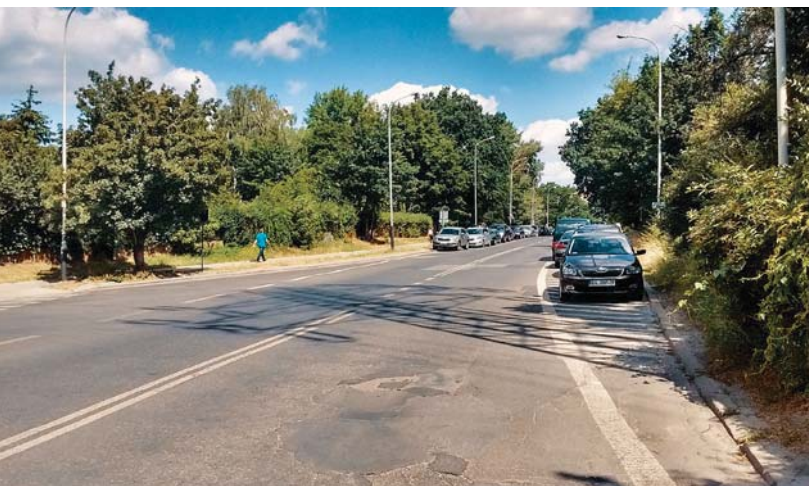
Fot. 3 i Fot. 4. Pasy rowerowe przy ul. Pankiewicza w Łodzi kończą się parkingiem z wyznaczonym na jezdni obejściem pieszym. Rozwiązanie tego miejsca jest dosyć niejasne – mimo braku odpowiedniego oznaczenia niektórzy rowerzyści mogą uważać je za kontynuację pasa rowerowego. Widok w kierunku ul. Wojska Polskiego
