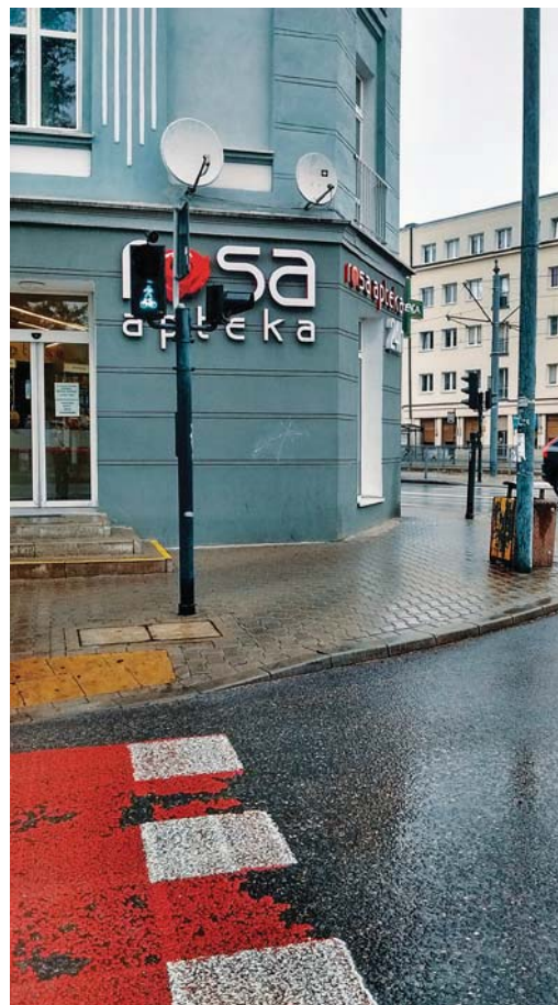
Fot. 7. „Śmieszka rowerowa” przy ul. Zachodniej. Problematyczny, wąski narożnik. Brak ciągłości ścieżki (czerwony asfalt) przy skrzyżowaniu z ul. Lutomierską
