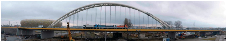
Rys. 7. Ustawienie U2 obciążenia próbnego
