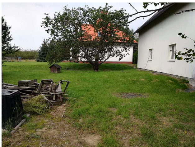
Ryc. 2. Współczesne budynki Kępy Kiełpińskiej posadowione na olęderskich nasypach (terpach) (fot. U. Zawadzka-Pawlewska)
