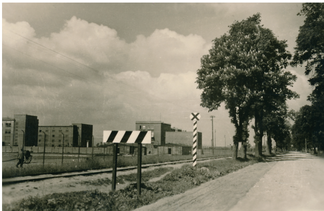
Fot. 2. Tory kolejowe biegnące wzdłuż obecnej al. Jana Pawła II Fotografia: wł. prywatna
