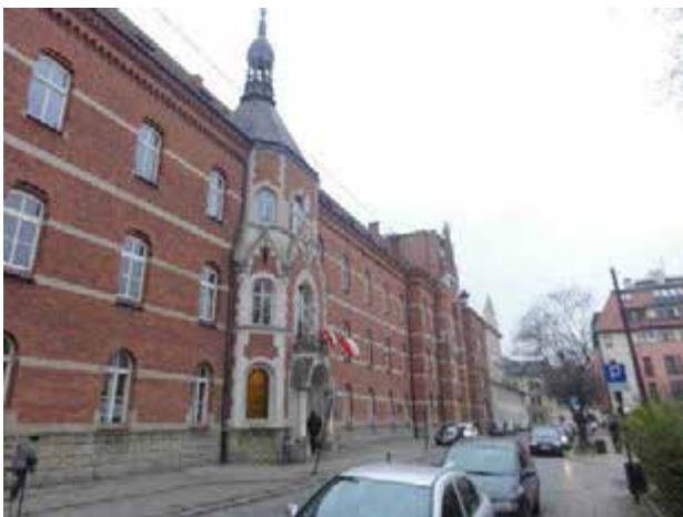
Il. 3. Obiekt wpisany do rejestru zabytków: ul. Trynitarńska 11 — Szpital oo. Bonifratrów.
