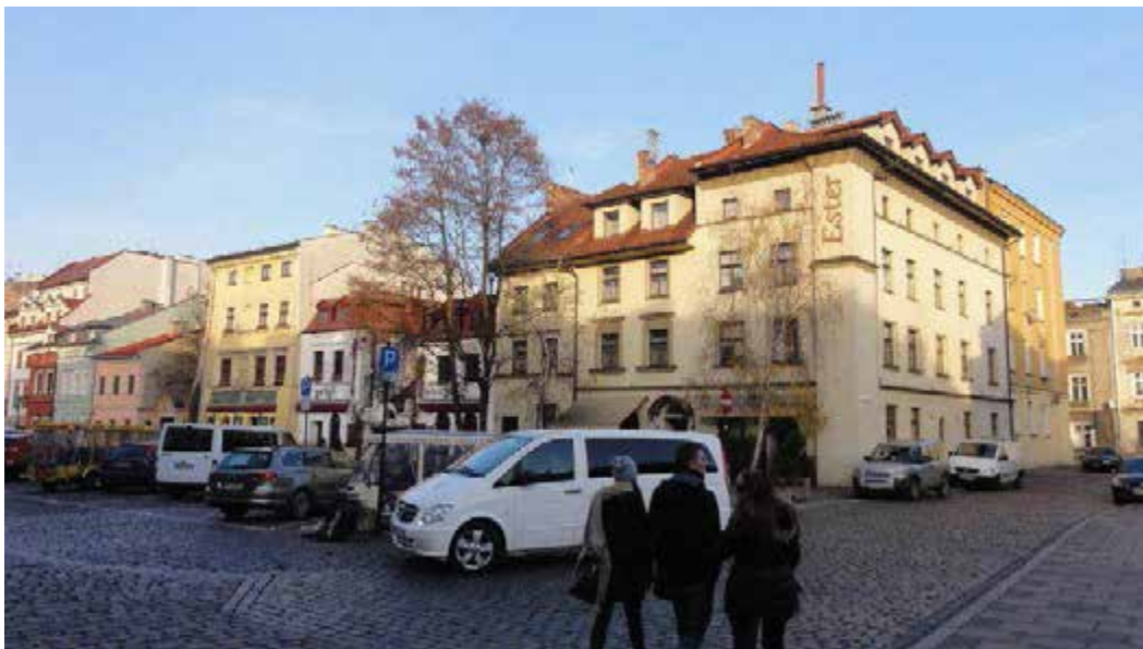
Il. 18. Zróznicowana linia nieba (skyline) ulicy Szerokiej, wskazywany do ochrony ustaleniami mpzp.
