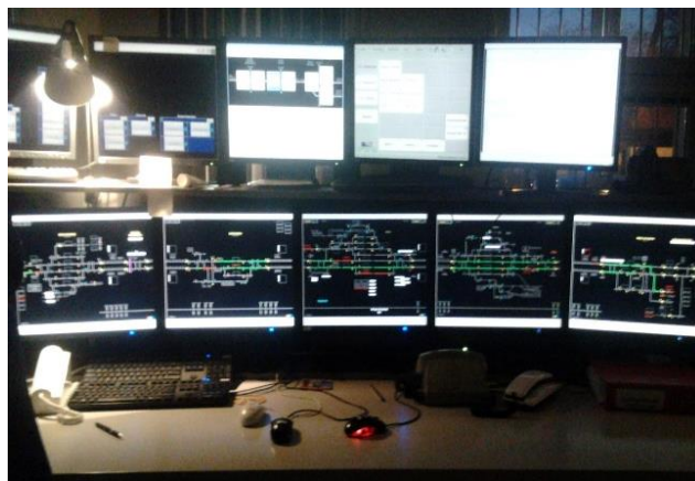
Rys. 2. Centrum Utrzymania i Diagnostyki w LCS Opole Główne [14]
