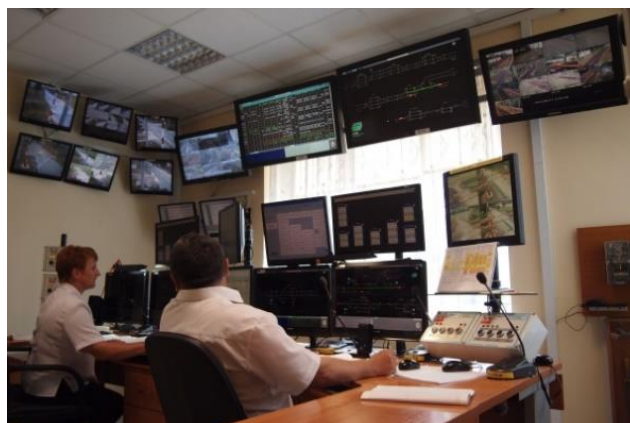
Rys. 3. Wyposażenie LCS Drzewica w nowoczesne rozwiązania prowadzenia ruchu kolejowego i komputery CUiD [16]
