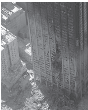
Rys. 1. Bankers Trust Building z widocznym uszkodzeniem fragmentu słupa [W1]
