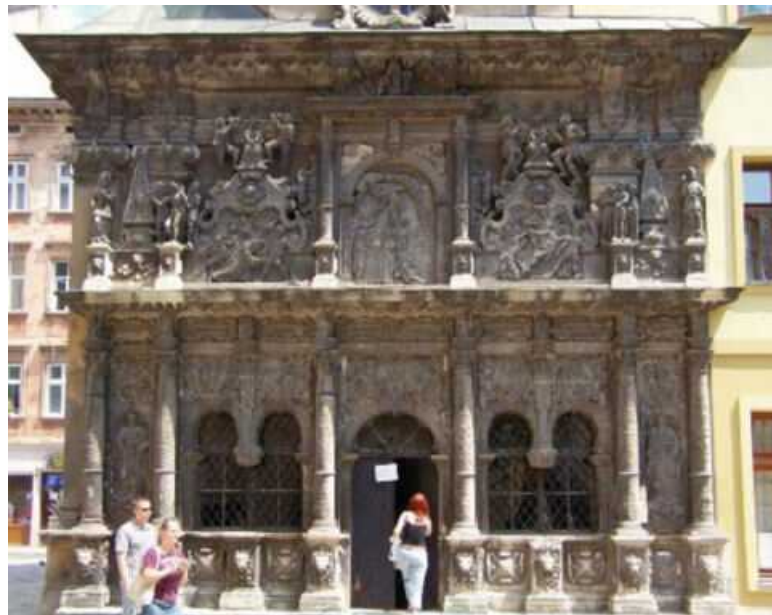
Il. 6. Lwów. Kaplica Boimów, arcydzieło manieryzmu (1615 r.), w sąsiedztwie Katedry, jest lwowskim arcyzabytkiem światowej klasy oraz miejscem kultu (fot. J. Partyka).
