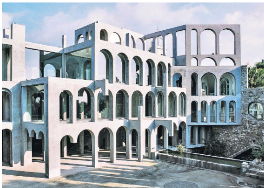
Fig. 1. Xavier Corbero's house. Source: [1] Ryc. 1. Dom Xaviera Corbero. Źródło: [1]
