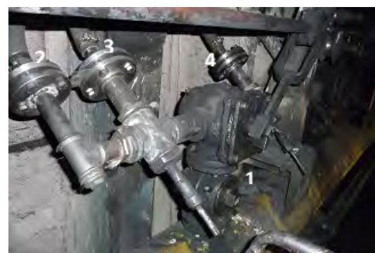
Rys. 6 Schemat testowej instalacji regulacji podaży gazu opałowego do skrajnego kanału grzewczego oraz jej rzeczywisty jej obraz: a) widok wlotu do ceramicznego kanału gazowego z indywidualnym doprowadzeniem gazu do kanału skrajnego (7) i pozostałych kanałów nieparzystych, b) widok instalacji zasilającej z gazowego kolektora głównego z usytuowaniem miejsc (kolnierzy 1-4) montażu elementów regulacyjnych (diafragm).
