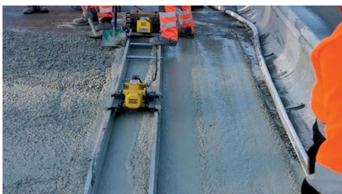
Fot. 18. Wibrowanie za pomocą łąty wibracyjnej nowego elementu nawierzchni [7]
