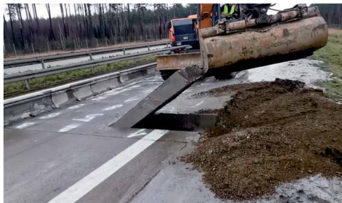
Fot. 10. Usunięcie starej nawierzchni za pomocą koparki [7]
