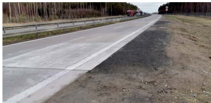
Fot. 23. Nowa nawierzchnia po oddaniu do ruchu [4]
