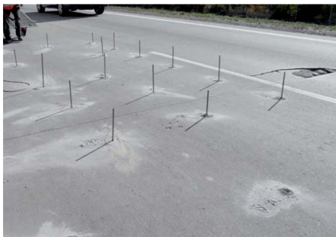
Fot. 8. Wzmocnienie konstrukcji pasa wewnętrznego poprzez wykonanie iniekcji wraz ze szczelinowaniem hydraulicznym za pomocą geopolimerów: a) strona lewa: przygotowanie punktów do iniekcji w nawierzchni, b) strona prawa: aplikacja geopolimerów pod konstrukcję nawierzchni betonowej [7]
