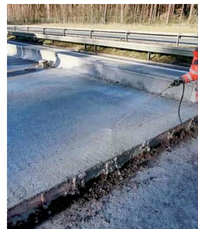
Fot. 20. Teksturowa nie poprzeczne i zabezpieczanie preparate m SIKA NB1 wykonane j nawierzchni [7]
