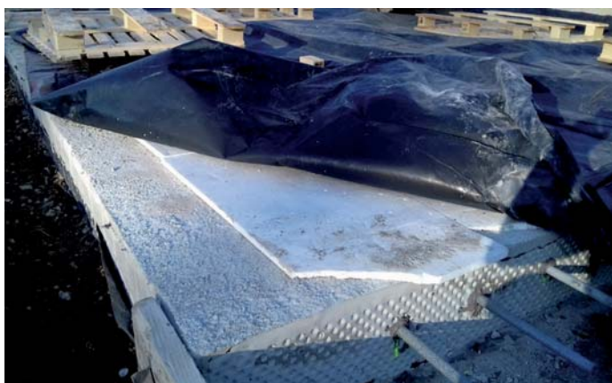
Fot. 22. Zabezpieczenie nawierzchni betonowej płytami ze styropianu i folią [7]
