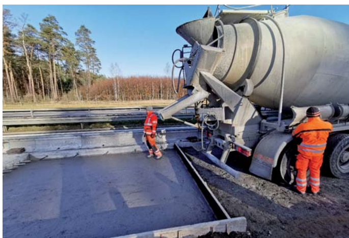
Fot. 16. Dojazd beczkowitzu w bezpośrednie sąsiedztwo aplikacji betonu szybkostrawnego [7]
