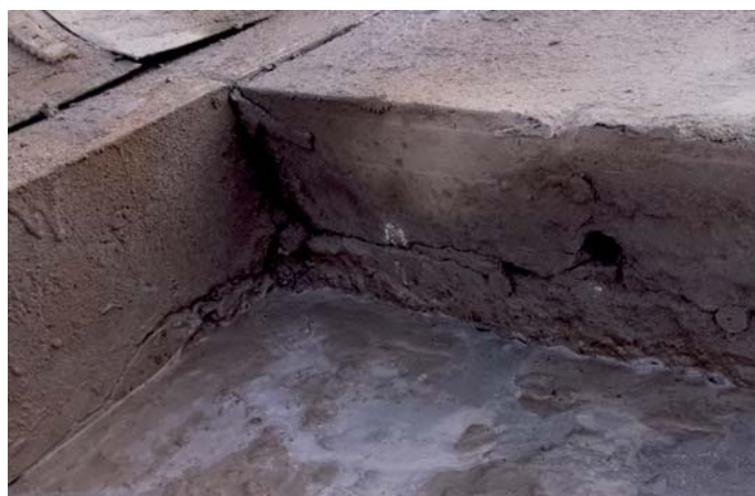
Fot. 12. Uszkodzenie narożnika sąsiedniej płyty, który zostanie wzmocniony dodatkowym prętem umieszczonym skośnie [7]
