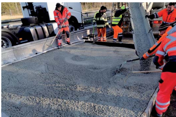
Fot. 17. Aplikacja i rozprowadzanie mieszanki szybkostrawnego betonu nawierzchniowego [7]
