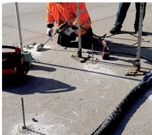
Fot. 8. Wzmocnienie konstrukcji pasa wewnętrznego poprzez wykonanie iniekcji wraz ze szczelinowaniem hydraulicznym za pomocą geopolimerów: a) strona lewa: przygotowanie punktów do iniekcji w nawierzchni, b) strona prawa: aplikacja geopolimerów pod konstrukcję nawierzchni betonowej [7]
