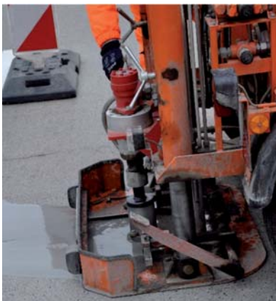
Fot. 6. Wykonywanie odwiertów w nawierzchni, autostrada A4, km 53+550 [7]
