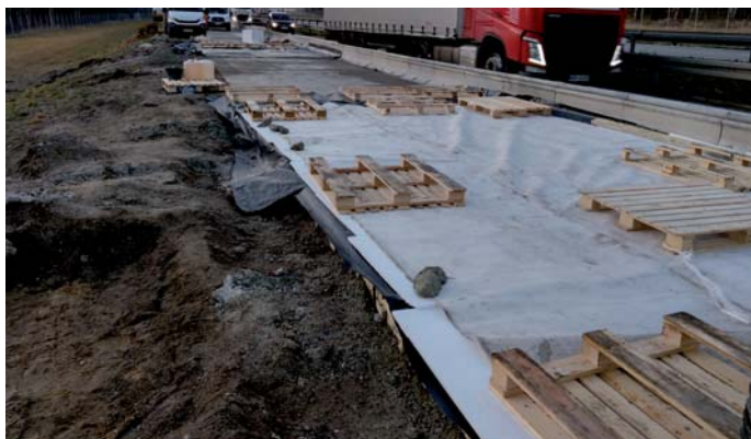
Fot. 21. Przykrycie nowej nawierzchni betonowej płytami ze styropianu oraz folią i zabezpieczenie przed wiatrem [7]
