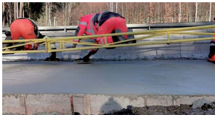
Fot. 19. Ręczne zaciera nie nawierzchni za pomocą pac tynkarskich z przesuwne go pomostu robocze go [7]
