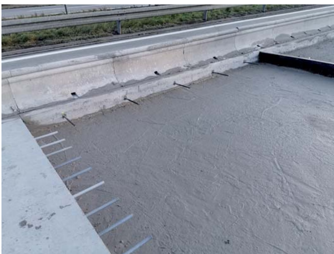
Fot. 14. Wyrównana i zabezpieczona warstwa podbudowy oraz osadzone nowe dyble i kotwy w sąsiednich płytach [7]
