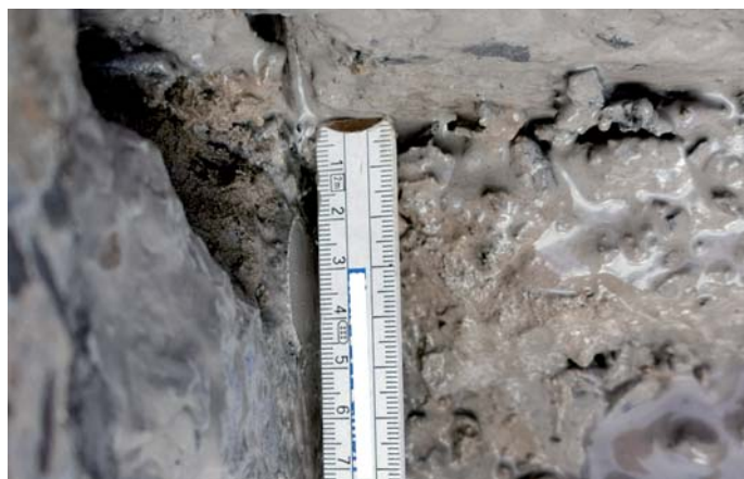
Fot. 11. Odległość dybla od powierzchni szczeliny podłużnej [7]
