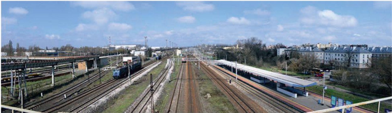
Fot 2. Obszar opracowania widziany z kładki na stacji Warszawa Praga w kierunku północnym. W oddali, po lewej stronie zdjęcia – komin Elek-trociepłowni Żerań. Na prawo – domy wielorodzinne przy ul. Pożarowej i Oliwskiej. Fot. M. Duda 2021 Photo 2 The study area as seen from the footbridge at the Warszawa Praga station to the north. In the distance, on the left side of the photo – the chimney of the Żerań Heat and Power Plant. To the right – multi-family houses at Pożarowa and Oliwska streets. Photo M. Duda 2021
