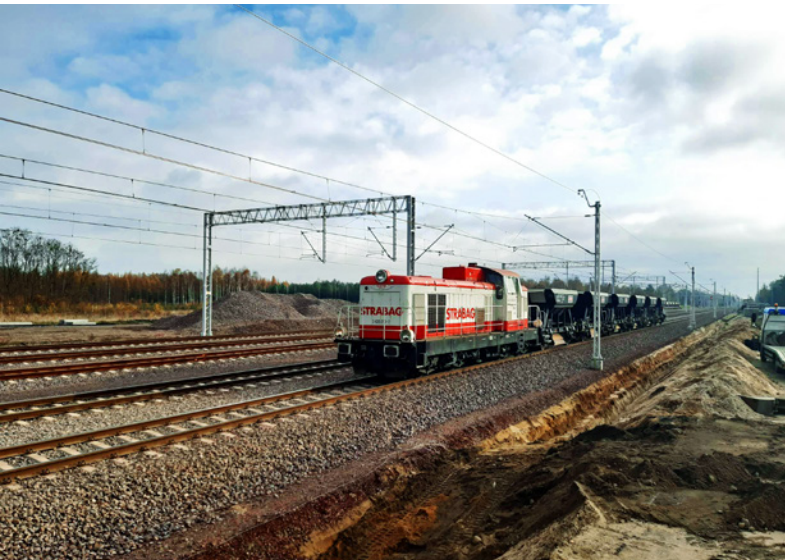
E59 na odcinku Wronki – Słonice
