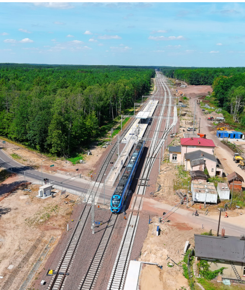
E59 na odcinku Dobiegniew – Słonice
