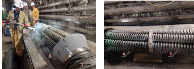
Rys. 7. Stanowisko czyszczenia: 1 – dysza, 2 – ssawa, 3 – przewód ssący, 4 – brudna część wymiennika, 5 – czysta część wymiennika Fig. 7. Cleaning station: 1 – nozzle, 2 – suction nozzle, 3 – suction pipe, 4 – dirty part of the exchanger, 5 – clean part of the exchanger
