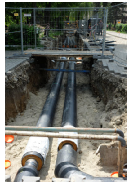
Fot. 2. Modernizacja sieci ciepłowniczych
