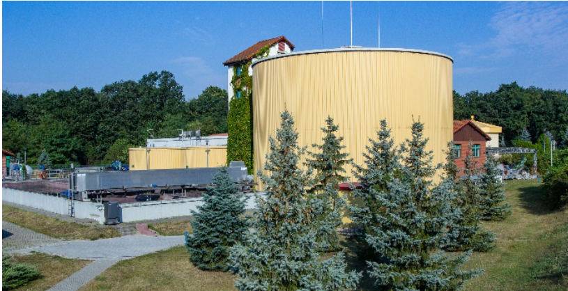
Fot. 2. Wydzielona komora fermentacji
