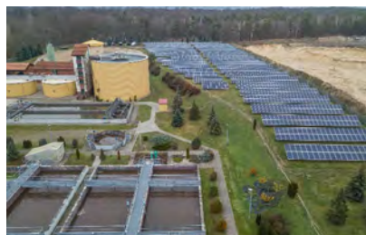
Fot. 1. Widok na oczyszczalnię ścieków Gubin-Guben
